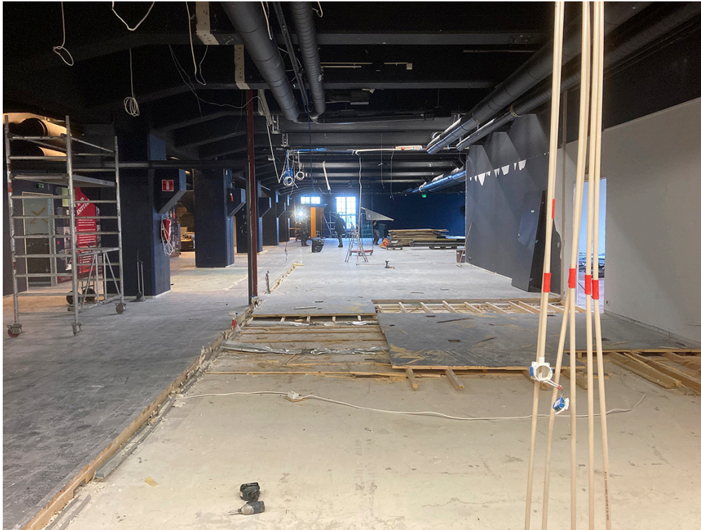
Korotettu puulattia purettiin ja alta paljastunut alkuperäinen betonilattia hiottiin ja lakattiin. Osa vanhoista väliseinistä voitiin säästää ja hyödyntää osana uutta arkkitehtisuunnitelmaa. Myös muita vanhoja rakenteita, kuten ovia, sisäikkunoita ja valaisimia uusiokäytettiin mahdollisuuksien mukaan. Kuva: Meri Eerola.
